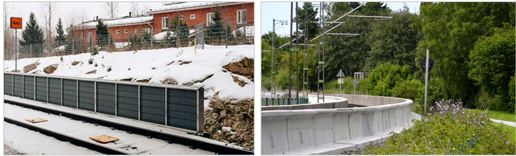
Kuva 5. Esimerkkejä matalasta meluesteestä rataympäristössä. Kuvat © Destia Oy 2017, Z-Bloc Norden AB 2023.
