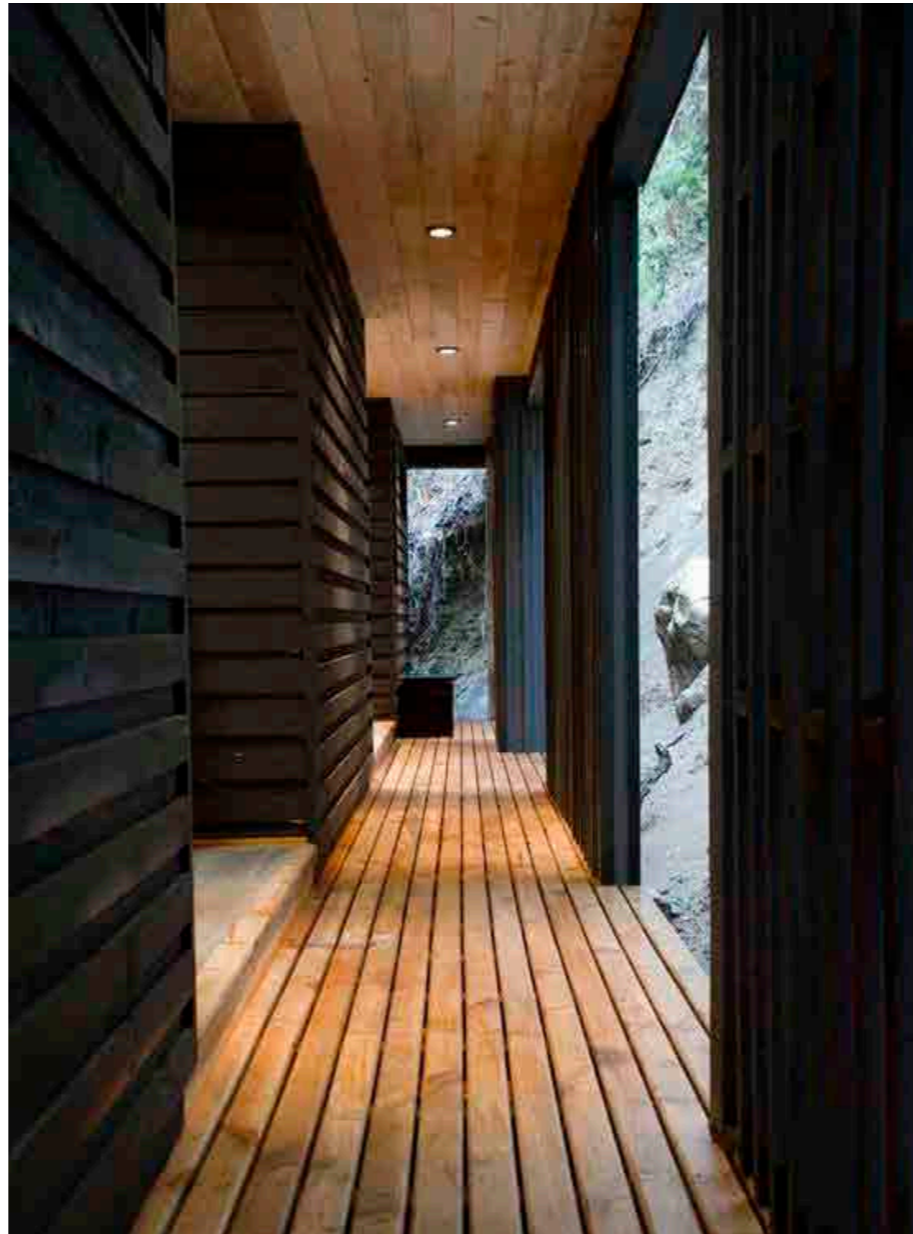
Kuva: Katoksen suojaavuutta lisätty seinäkkeillä
