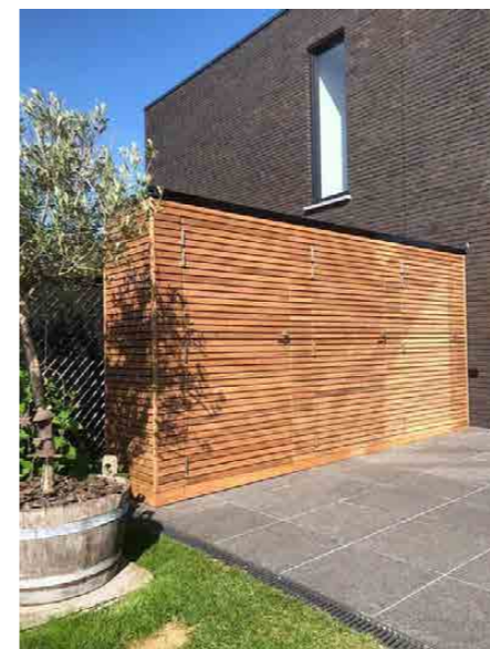
Kuva: Rakennukseen yhdistetty jätekatos
