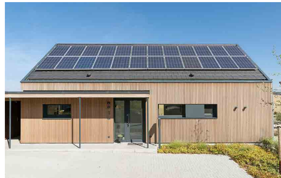
Kuva: Kattomuotoon integroidut aurinkopaneelit
