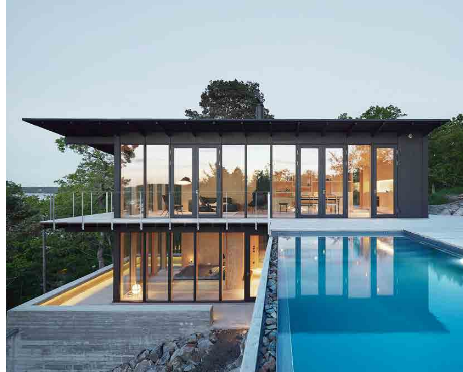
Bild: Det plana takets takföt skapar ett skyddstak
