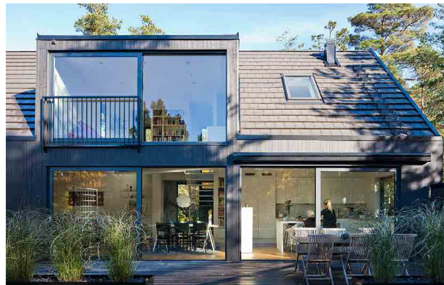
Bild: Tak av platta takpannor
