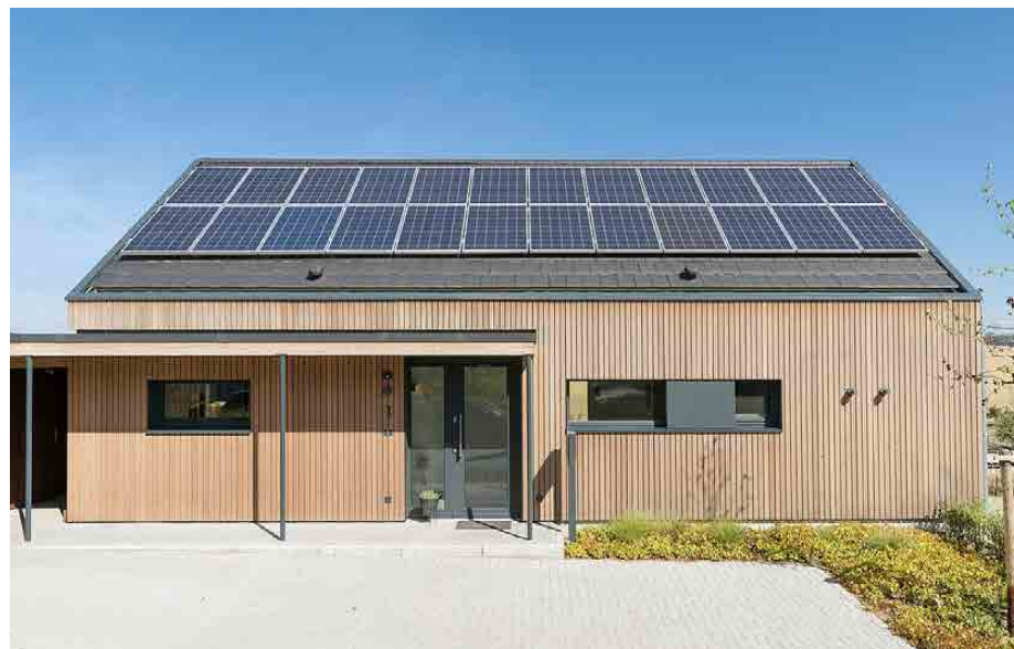
Bild: Solpaneler integrerade i takformen
