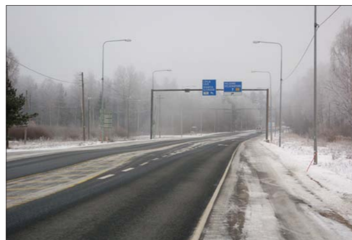
Kuva 5. Kantatien 51 ja maantien 115 liittymäalue lännestä nähtynä.
