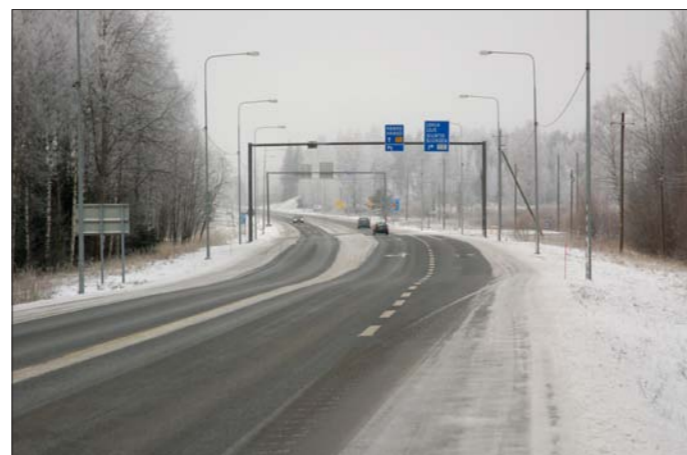
Kuva 4. Kantatien 51 ja maantien 115 liittymäalue idästä nähtynä.
