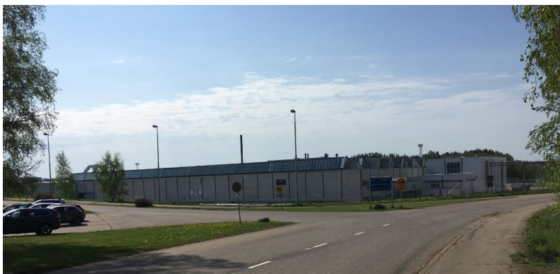
Kuva 19 Teollista rakentamista Kirkkonummen kuntarajalta
