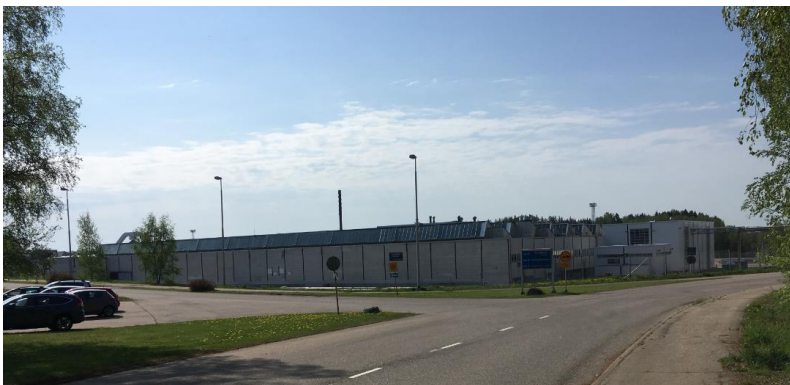
Kuva 20 Teollista rakentamista Kirkkonummen kuntarajalta.
